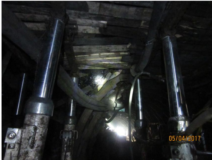
Rys. 8. Przebudowa (wymiana obudowy chodnikowej na indywidualną stalowo-członową przed frontem ściany w tureckiej kopalni IMBAT [13])
