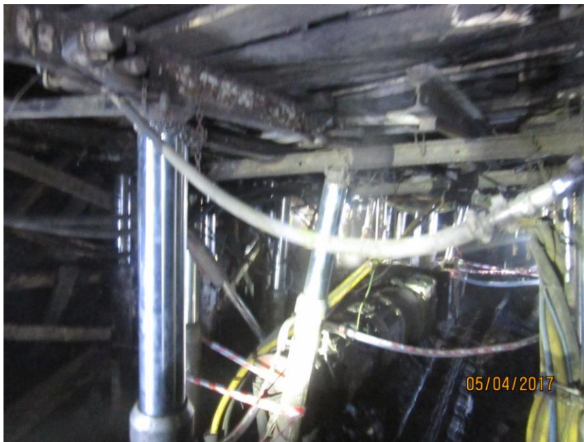
Rys. 9. Zabudowa skrzyżowania ściana-chodnik w jednej z kopalń tureckich [13]
